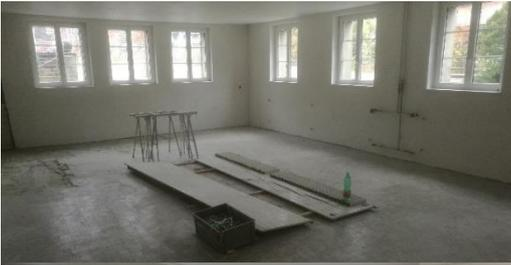
Der neue Raum für die Kindergärteler ist inzwischen leergeräumt und die Wände wurden verputzt. Anschliessend werden die neuen Schränke eingebaut und die Heizkörper wieder montiert. Bevor während des Herbstunterbruchs die Baureinigung durchgeführt werden kann, wird die Elektroinstallation fertiggestellt und ein neuer Bodenbelag verlegt.
