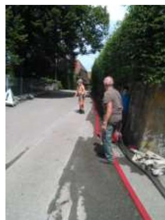
Sie besorgten eine rotierende Brunnrute, die von einer Seite her in die Leitung geschoben wurde, während von der Gegenseite mit Wasserdruck die gelösten Kalkstücke ausgespült wurden. Beim nächsten Schacht wurden diese Stücke (zum Teil 80cm lang) aufgefangen und herausgeholt. Da half als 3. Mann Ernst Stettler tatkräftig mit.
