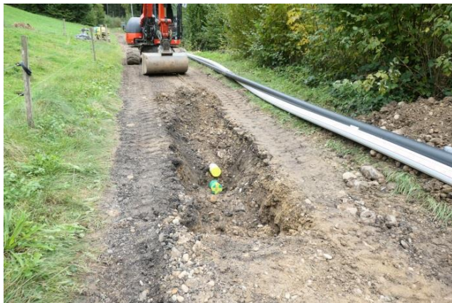
Der Pflug stösst auf ein Hindernis: Der Bagger findet einen uralten Baumstamm, längs in der Strasse vergraben.
