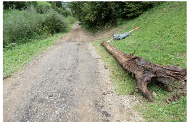
Der Pflug stösst auf ein Hindernis: Der Bagger findet einen uralten Baumstamm, längs in der Strasse vergraben.
