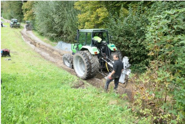
Die Leitungen werden zum Teil eingepflügt (Wirth, Wasen i.E.).
