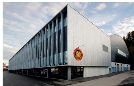
Sanierung & Erweiterung Ilfishalle zinsloses Darlehen, Bereich innovative regionale Angebote
