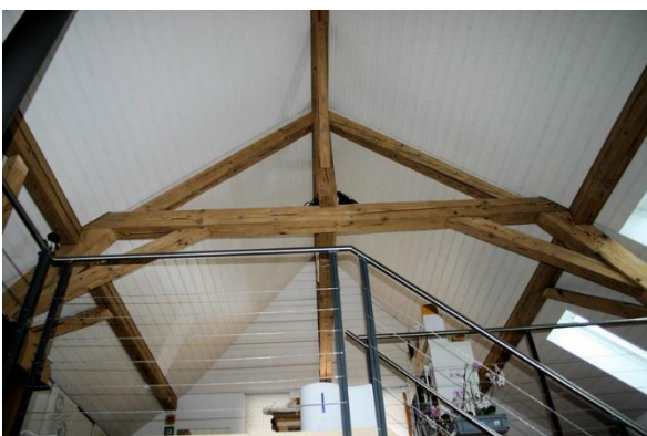
Innenausbau Wand- und Deckenverkleidungen Isolationen mit verschiedenen Materialien, auch mit Schafwolle
