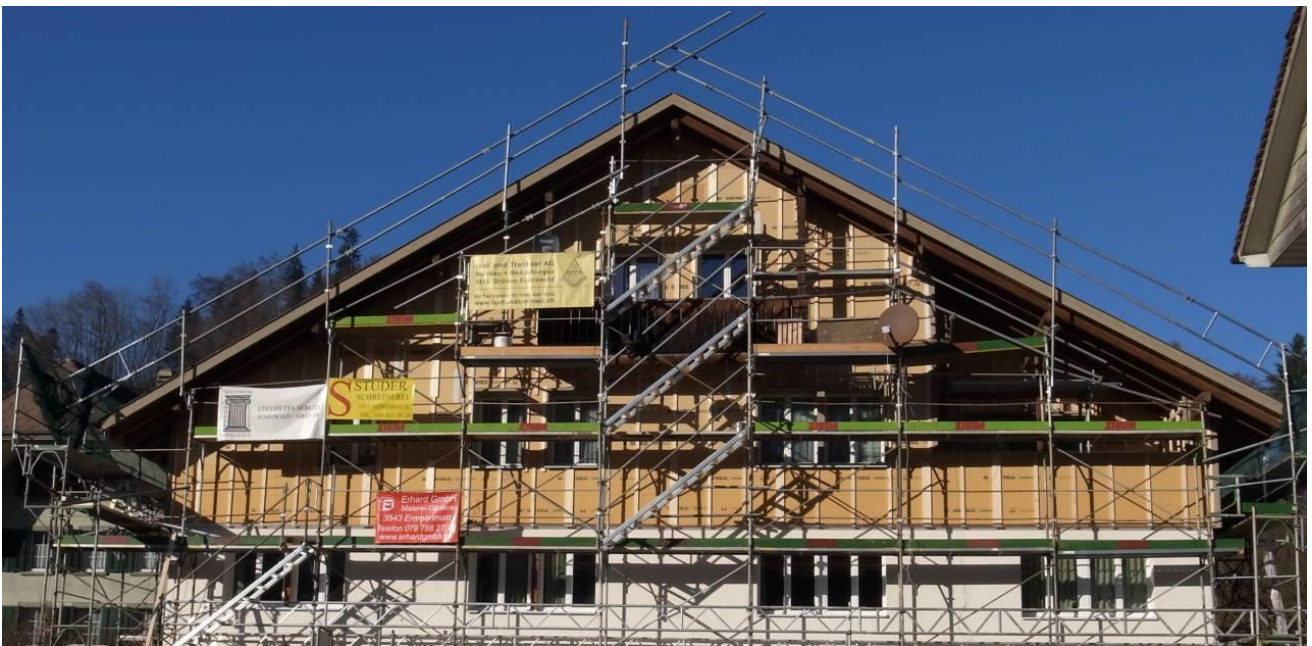
Kürzlich konnte die Sanierung des Gemeindehauses abgeschlossen werden.
