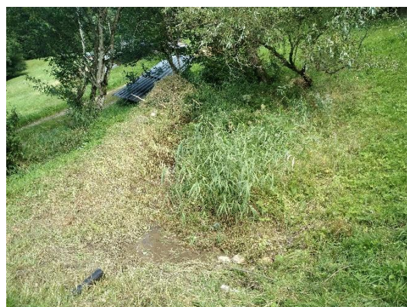
Sickergrube, wirkt als Nachfilter
