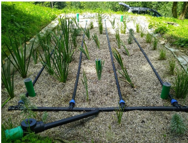
Pflanzenfilter mit Verteiler
