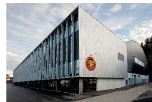
Sanierung & Erweiterung Ilfishalle zinsloses Darlehen, Bereich innovative regionale Angebote
